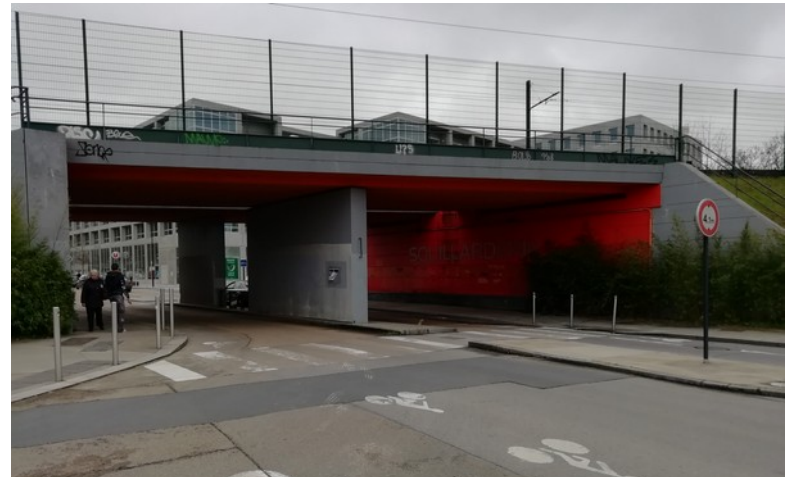
Route de Sainte-Luce – passage sous la voie ferrée au niveau de l'arrêt de tram Ligne 1 Soullarderie (crédit photo : Inddigo)
