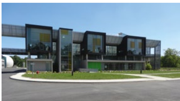
Station d'épuration Petite-Californie
