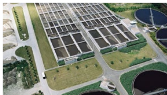
Station d'épuration de Tougas
