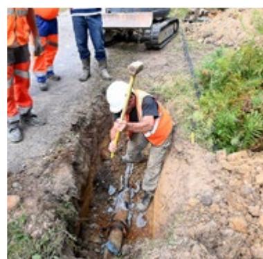
Renouvellement d'une canalisation par éclatement rue de la Cossonnière, Le Pellerin
