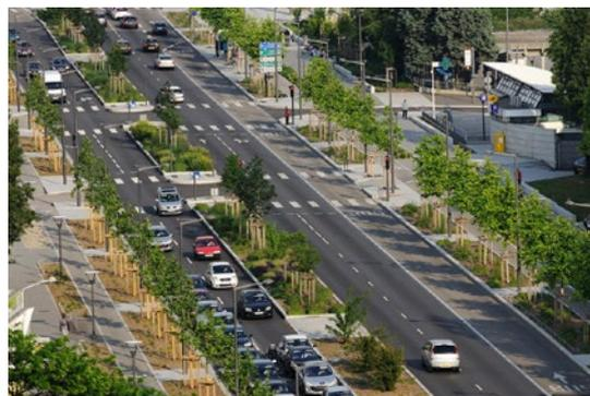
**Exemple de la requalification d'une avenue à Lyon : l'ensemble des terre-pleins et des bandes végétalisées qui séparent les voies sont en creux et collectent les eaux pluviales**
