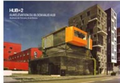
**Thème :** Surélévation du blockhaus Hub sous forme de Structure déplaçable entièrement boulonnée
