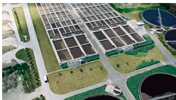
Station d'épuration de Tougas
