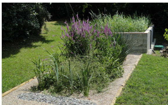
Filtres plantés, un assainissement non collectif naturel
