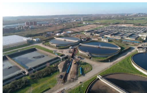
Chantier conduites de recirculation des boues, station de Tougas
