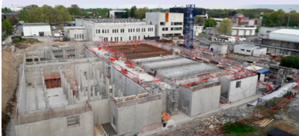
Construction des filtres à sable
