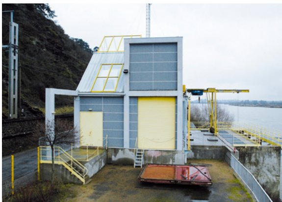
Station de pompage de Mauves sur Loire
