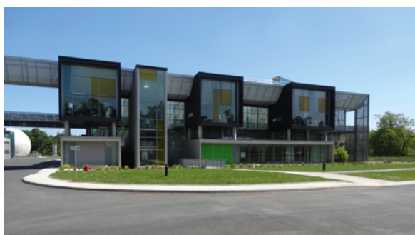
Station d'épuration Petite-Californie
