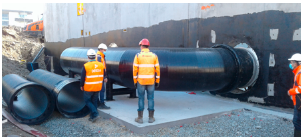
Nouveau bâtiment de pompage des eaux traitées
