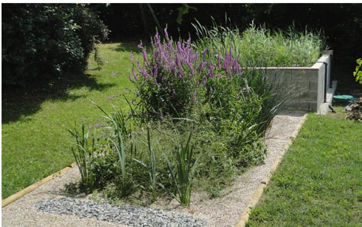
Filtres plantés, un assainissement non collectif naturel
