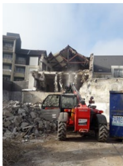
Démolition préalable aux travaux, BSR Barbin
