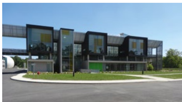
Station d'épuration Petite-Californie
